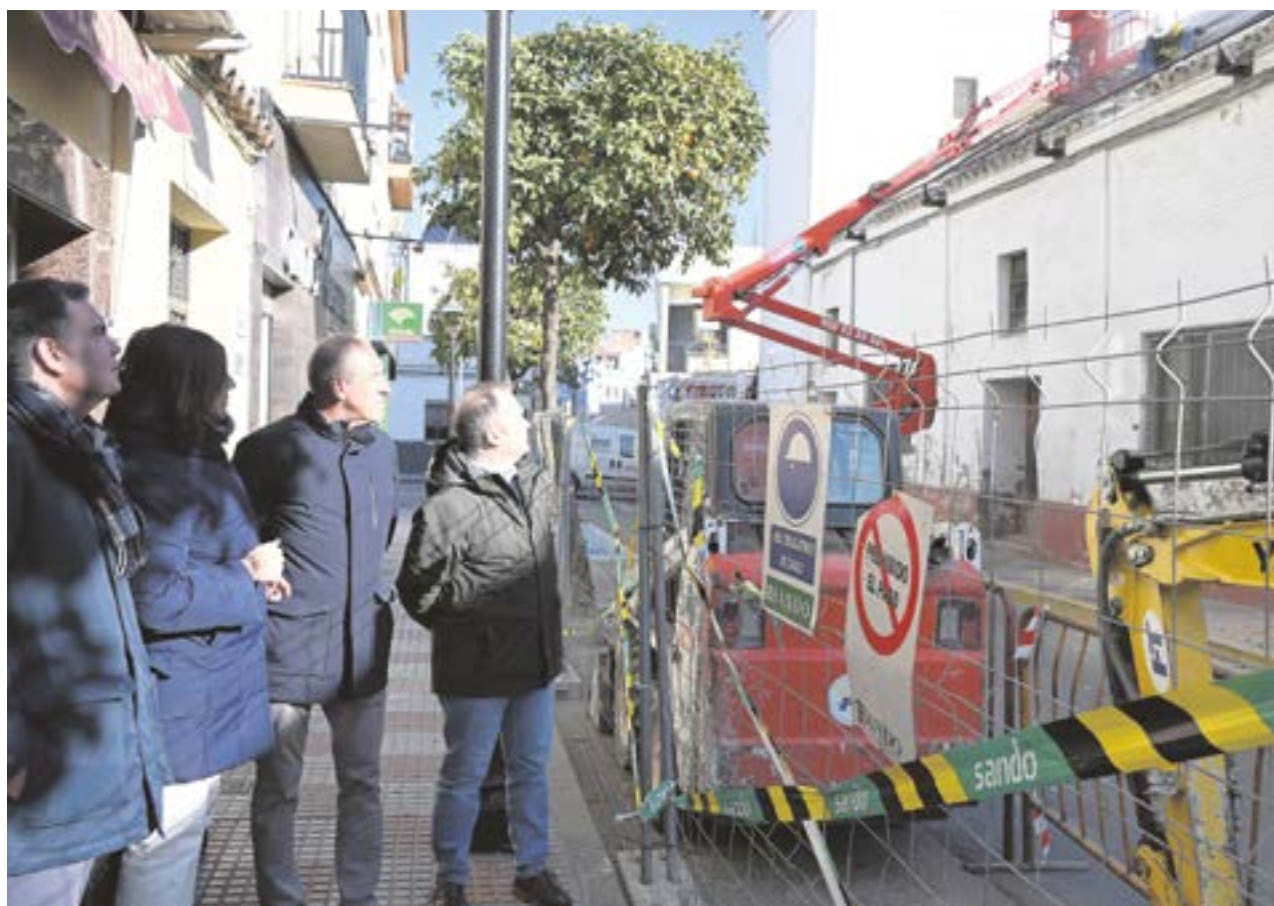
El alcalde, José María Soriano, el concejal de Urbanismo, Miguel García de la Rosa y técnicos visitando las obras
